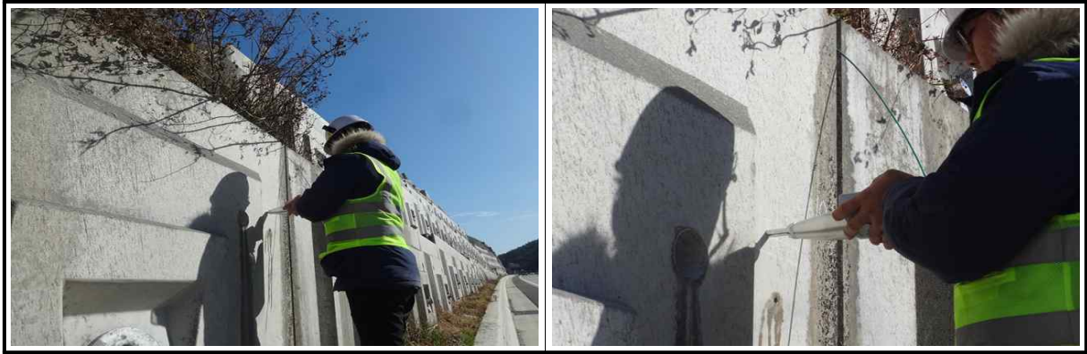
【그림 6.3.6】 슈미트해머를 이용한 반발경도시험 전경
